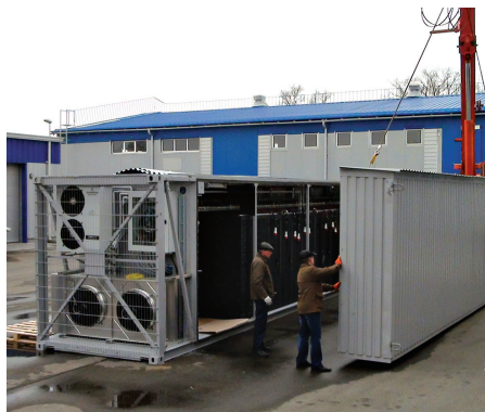
Рис. 2. Монтаж съемного горячего коридора перед стартом заводского тестирования инженерной инфраструктуры МЦОД
