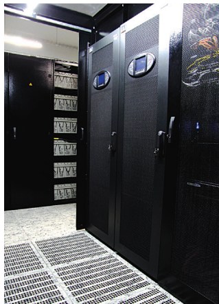
Рис. 1. Модульные ИБП Vertiv Liebert APM, обеспечивающие резервирование 2(N+1)
