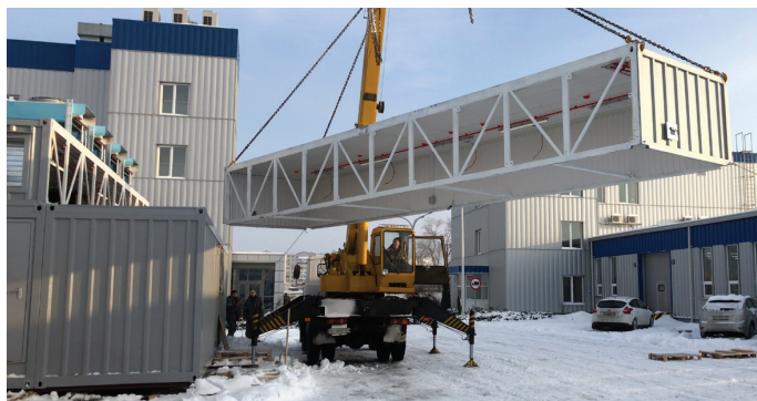
Рис. Процесс сборки МЦОД по заказу IT-Solutions для крупной государственной структуры
